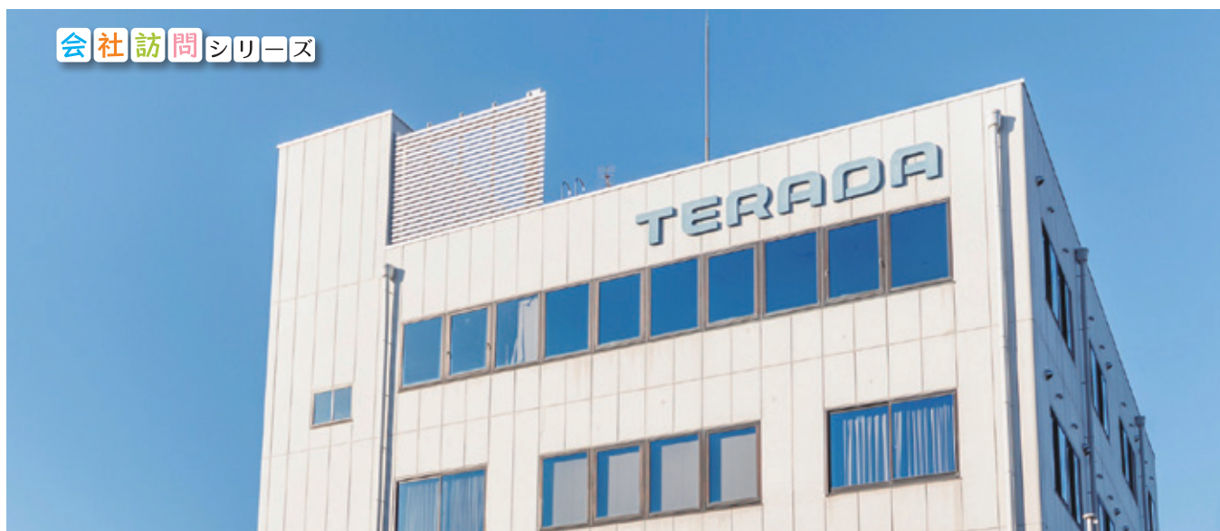
株式会社寺田ポンプ製作所 本社社屋
